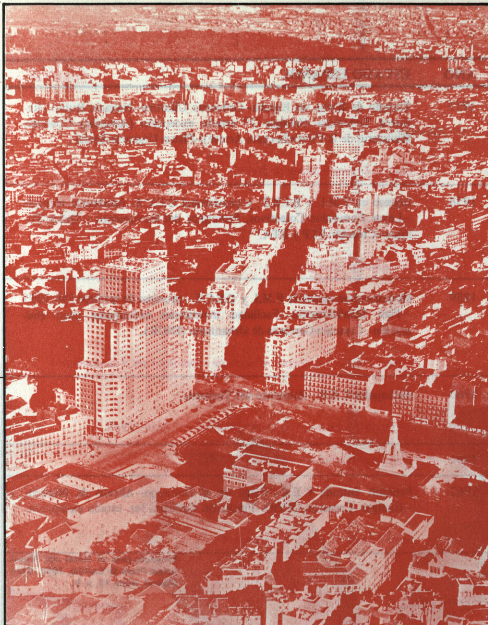
Terminado el edificio España se inicia la construcción de la Torre de Madrid. 1951. Gran Madrid, núm. 14, p. 14.
